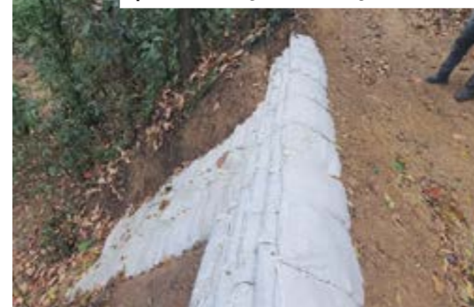
Após intervenção- Contenção de encosta
