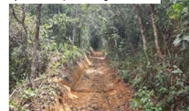
Após intervenção- Drenagem em vala
