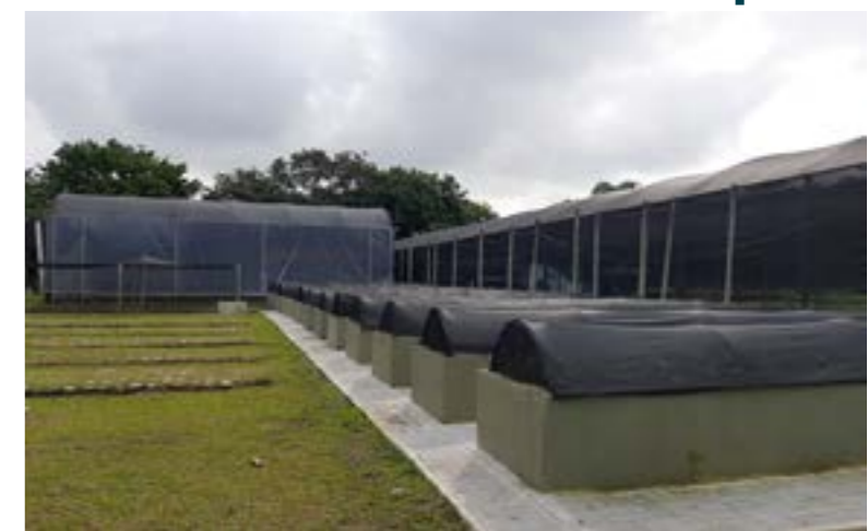
Berçários de mudas e as estufas, foram itens requalificados pela ECP Environmental Solutions, além de toda reforma da sede, foi instalado o sistema de irrigação automatizado e toda estrutura de esgotamento sanitário foi readaptada.
